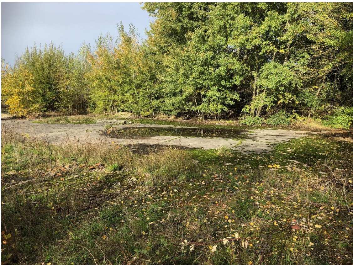
Photographie 4 : Exemple de dalle des anciens bâtiments militaires – BURGEAP 2020
