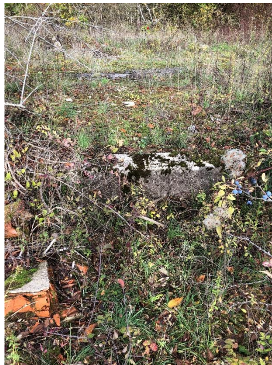
Photographie 2 : Muret dans la zone Sud – BURGEAP 28/10/2020
